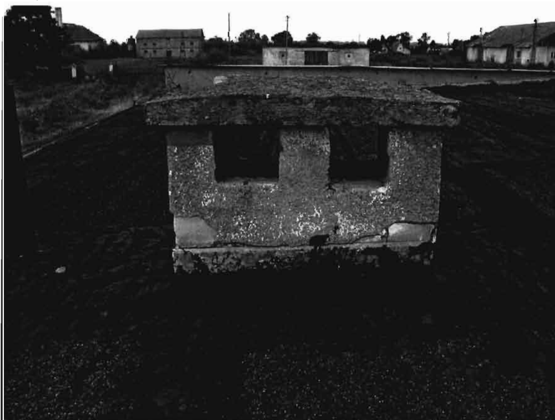
Zdjęcie Z-7 . Komin wentylacyjny Nr 1 (chlorownia, W.C.), do przemurowania
