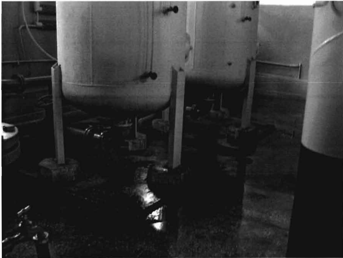
Zdjęcie Z-16. Widok posadzki w pomieszczeniu hali technologicznej.
