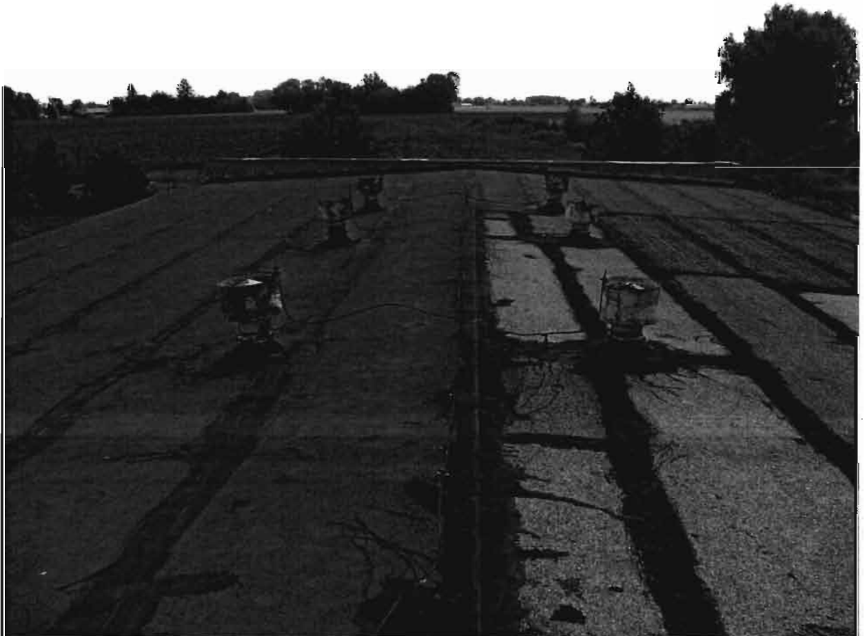
Zdjęcie Z-9. Ogólny widok powierzchni stropodachu.
