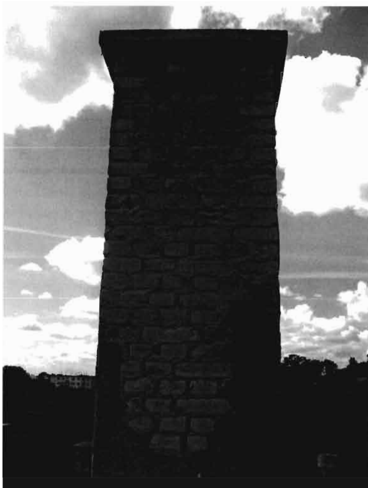
Zdjęcie Z-6 . Rozszczelniony komin C.O. Odpadający i zagrzybiony tynk. Przemieszczona „czapka” kominowa
