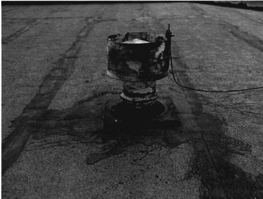
Zdjęcie Z-15 Wywietrzak dachowy
