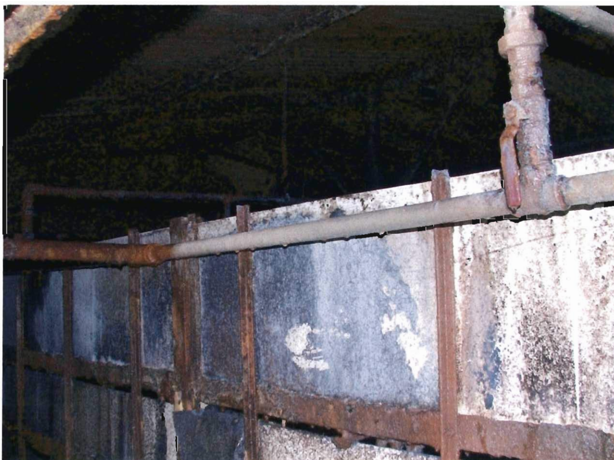
Z-6. Widok na burty złoża dolomitowo-lorfowego
