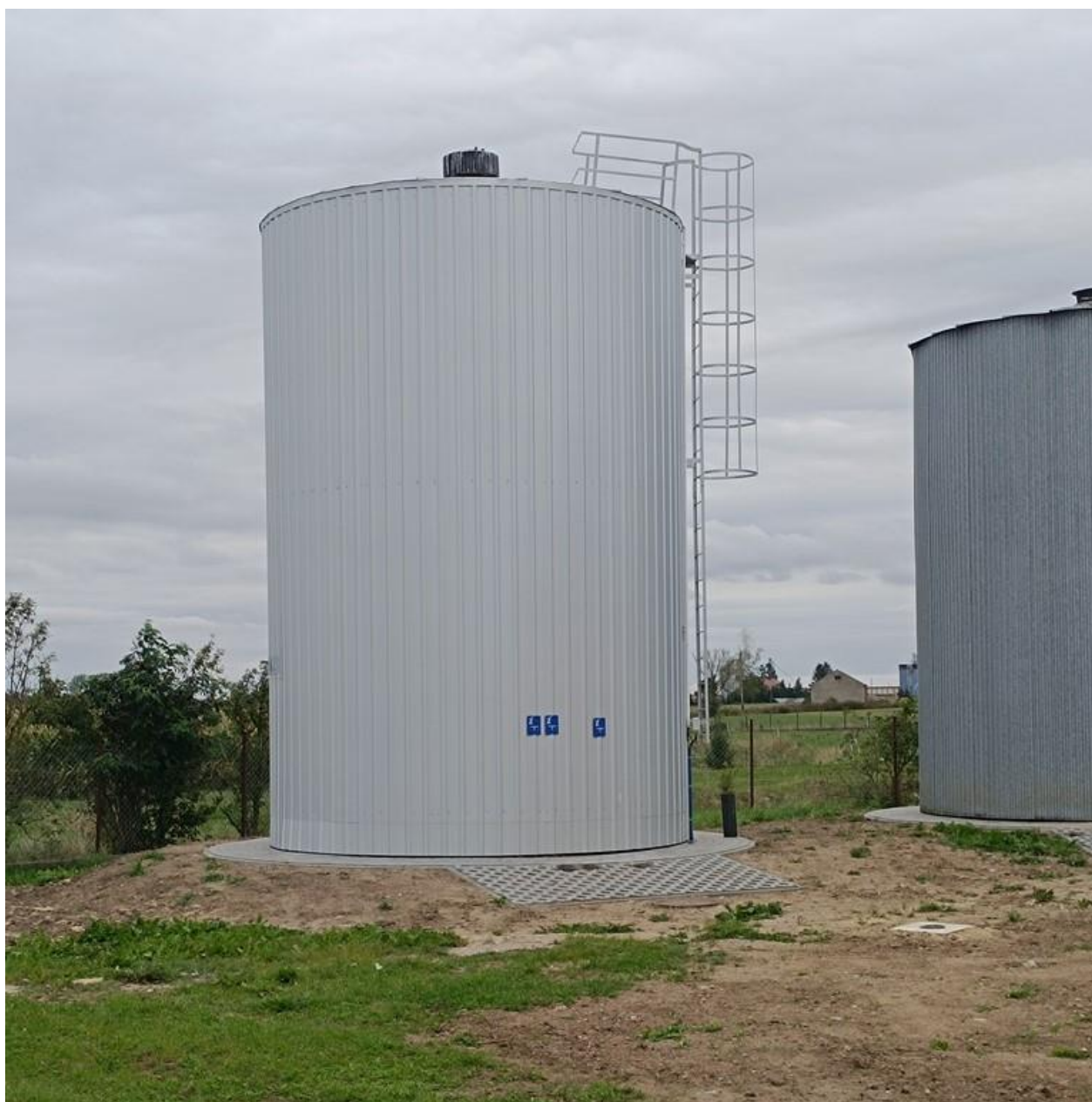
fot. Zbiornik rezerwowo wody na SUW w Trętowie.
