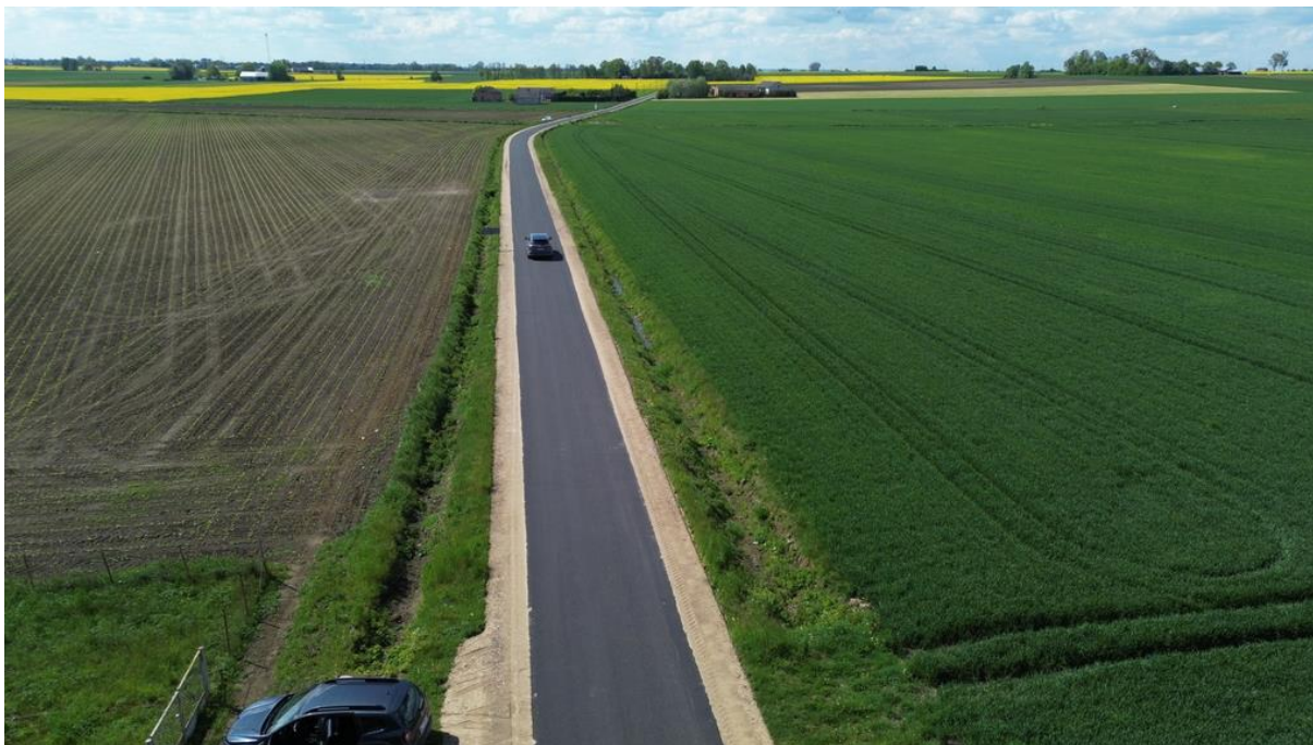
fot. Modernizacja drogi gminnej Janowięta - Wierzbowo Źródło: Urząd Gminy w Opinogórze Górnej
