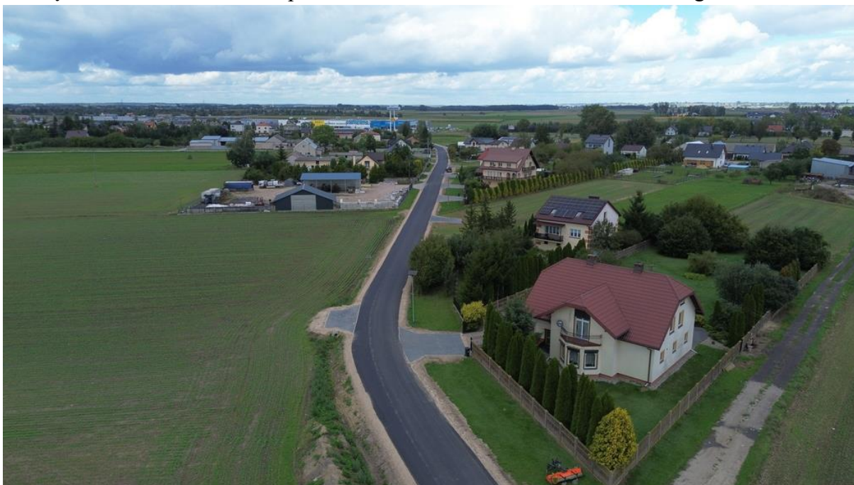
fot. Przebudowa drogi gminnej Chrzanówek (cz. ul. Kasztanowej)
