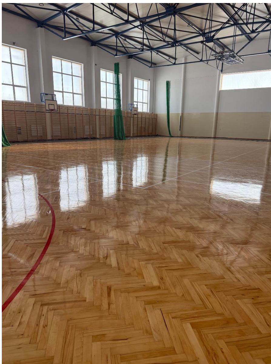
fot. Modernizacja hali sportowej w Opinogórze Górnej
