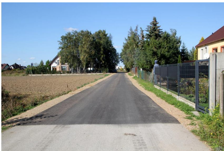
Fot. Przebudowana droga w Chrzanówku.
