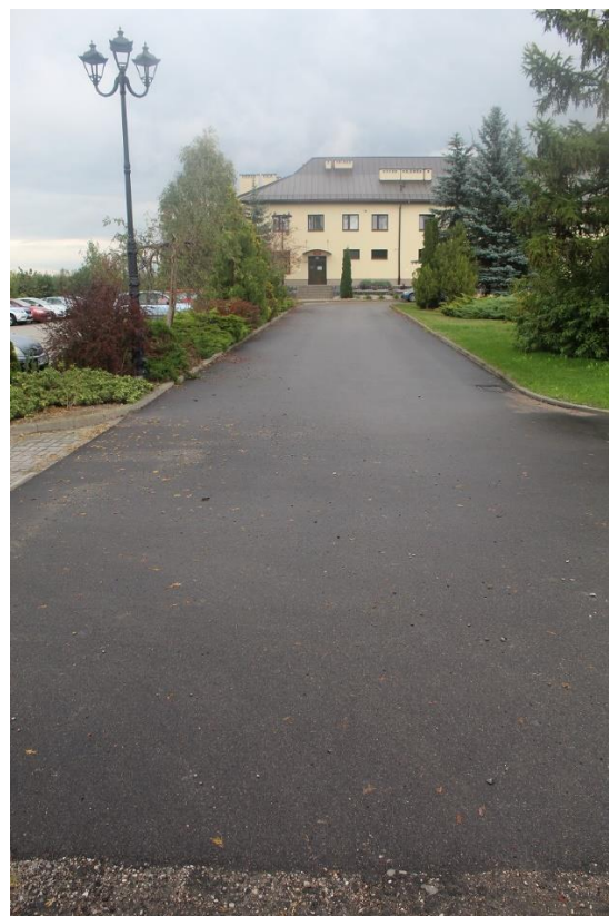
Opinogóra Górna (nowa nawierzchnia i oświetlenie drogi przed urzędem)
