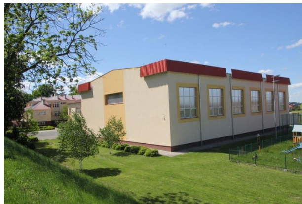
bud. hali sportowej po termomodernizacji
