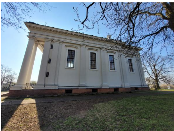
zdj. 3. Elewacja północna
