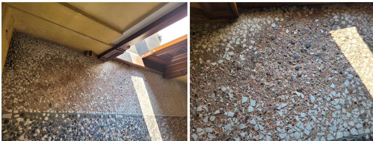
zdj. 9 i 10. Widok posadzki przewidzianej do renowacji w ramach zamówienia
