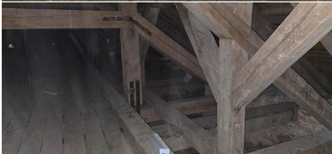
zdj. 7 i 8. Widok więźby dachowej
