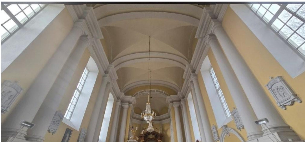
zdj. 5. Widok sklepienia kolebkowego nawy
