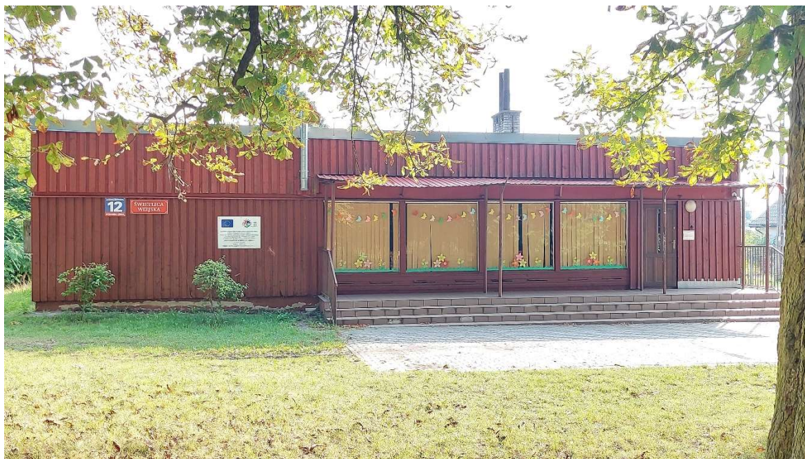
zdjęcie 1 - Elewacja południowo - zachodnia
