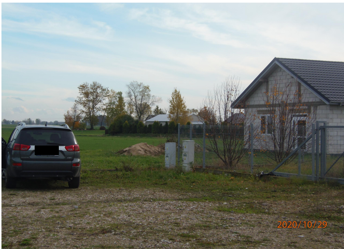
Fot.2. Widok na działkę nr 87/1 w miejscu projektowanej sieci wodociągowej; przejście przeciskiem /przewiertem . Fotografia Pracowni Projektowej wykonana w październiku 2020 r .
