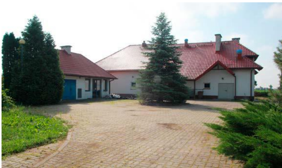
Fot. Oczyszczalnia ścieków w Opinogórze Górnej w 2021 r. po remoncie.
