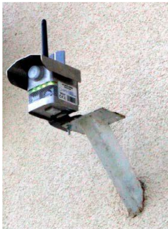
Fot. Czujnik zanieczyszczeń powietrza w Opinogórze Górnej.
