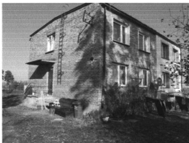
Widok ogólny budynku mieszczącego przedmiotowy lokal
