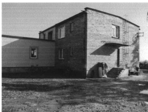
Widok ogólny budynku mieszczącego przedmiotowy lokal
